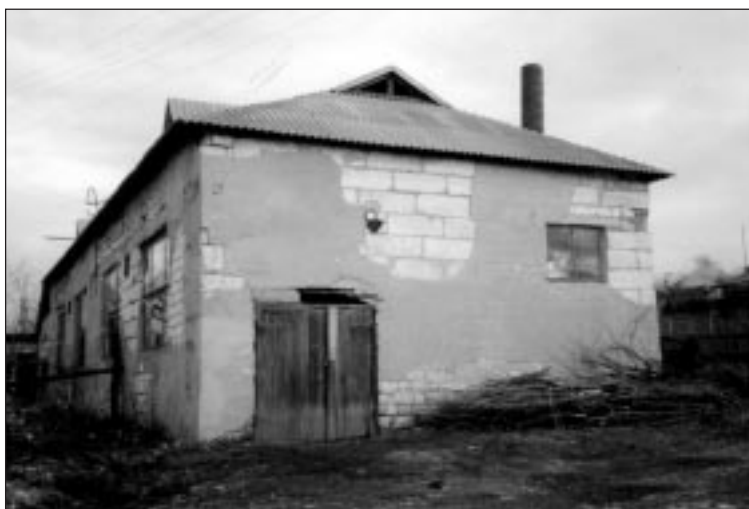
► Cazangerie uzată și depășită de timp
